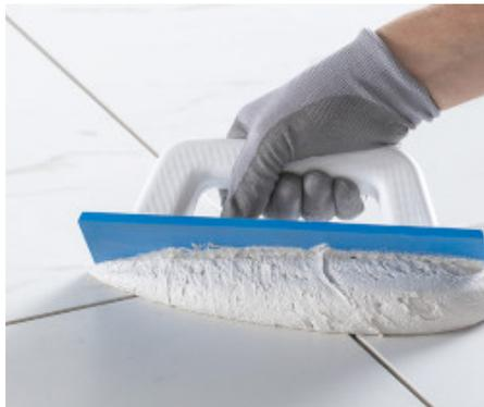
Kerapoxy Easy Design mit Mapei-Gummifugscheibe auftragen
