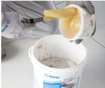
Zugabe des Härter (Komponente B) in das Gebinde der Komponente A
