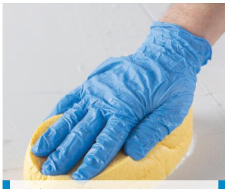
Einfache Reinigung und Nachbearbeitung mit einem Zelluloseschwamm
